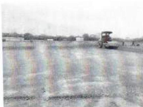
14.1.1. EXCAVACION MECANICA CONGLOMERADO. No incl. Reti: Se finaliza la excavación para las zapatas de la pista de patinaje la cual comprende una profundidad en la cual se garantiza la ubicación del concreto solado de limpieza y el concreto de las zapatas, dicha profundidad es verificada mediante topografía.
