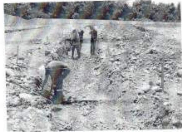
14.1.3. **ACERO REFUERZO FIGURADO 412MPa, (4200 kg/cm<sup>2</sup>,G60):** Se realiza la ubicación del acero figurado para los elementos de concreto de la pista de patinaje los cuales comprenden las zapatas y el muro de la pista de patinaje según los diseños estructurales donde se muestra el despiece de aceros.
