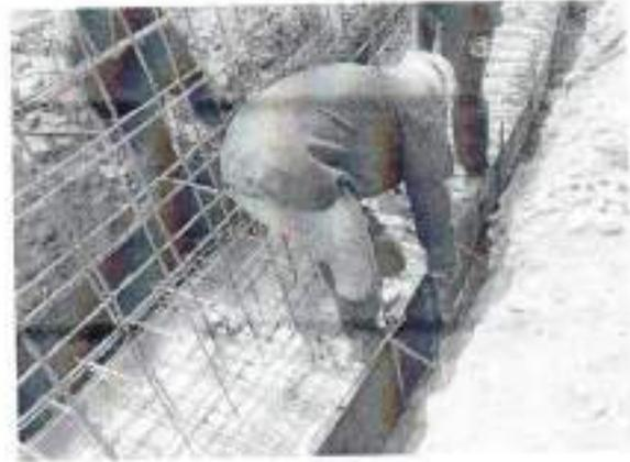
14.1.20. **CONCRETO ZAPATA 20,7 Mpa, (3000 psi) No inc hierro.:** Se realiza el vertido del concreto de 3000 PSI para las zapatas del muro de la pista BMX el cual costa de un espesor de 25 cm, el vertido es de concreto premezclado ubicado con mixer, el vibrado y el alistado del concreto es realizado por el personal de obra.
