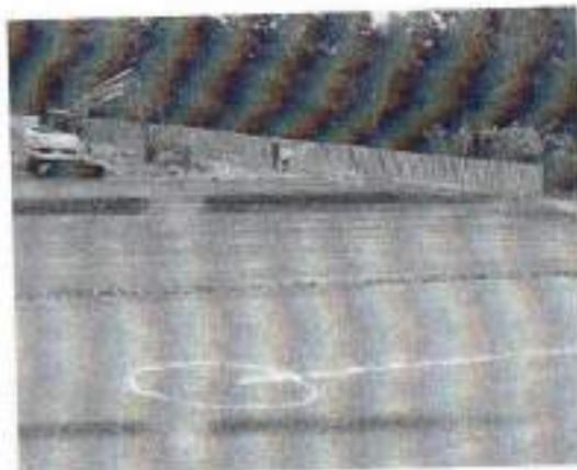
13.1.4 Base Tritura T. Max. 1 1/2". Inc. Transp 5 km: comprende al suministro, extendido y compactación del material tipo base el cual comprende un espesor de 15 cm la cual hace parte de la estructura de la cancha de futbol 5.
